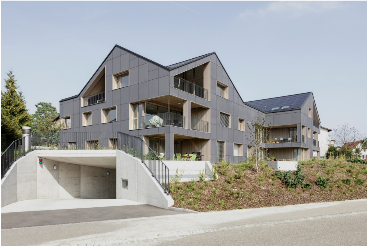
Komplett Energieautark auch im Winter, dank Brennstoffzellentechnologie und Wasserstoffelektrolyse. Das energieautarke Mehrfamilienhaus in Brütten (CH).
